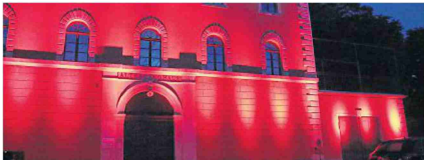
Diverse Gebäude in Herisau, darunter das Alte Zeughaus, leuchteten am Montag rot.
