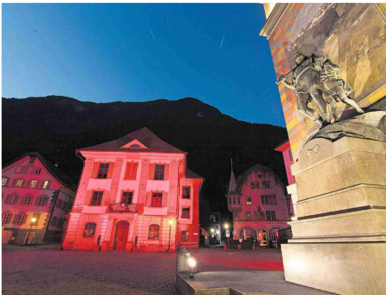
Das Urner Rathaus, hier beleuchtet im Rahmen der Aktion «Night of Light», wird diesen Sommer saniert.
