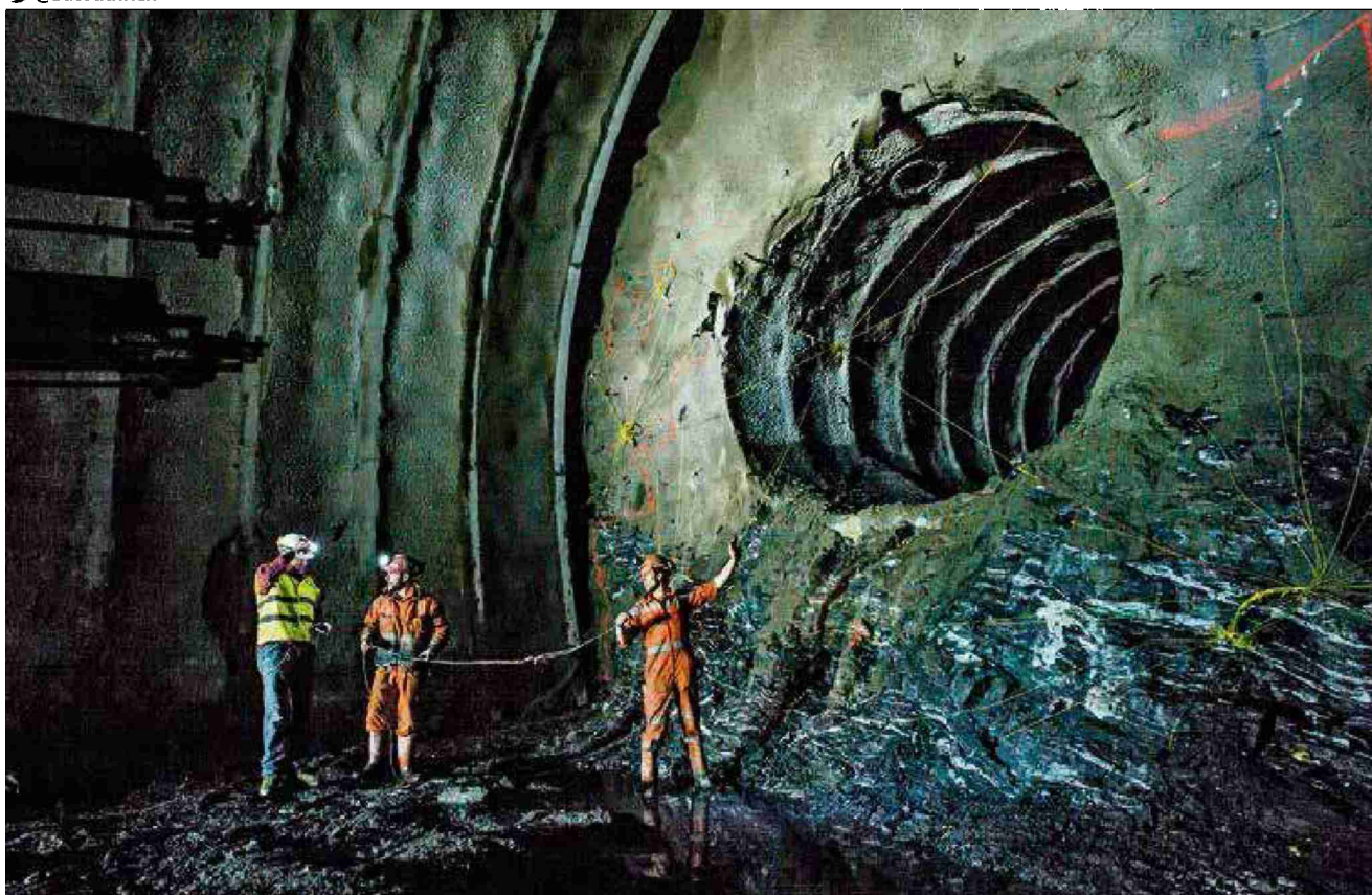
Construction de l'autoroute A9 vers Viège (VS). En 2015, l'administration fédérale a acquis à elle seule pour 5,65 milliards de travaux de construction, de marchandises et de services. (OLIVIER MAIRE/KEYSTONE)
