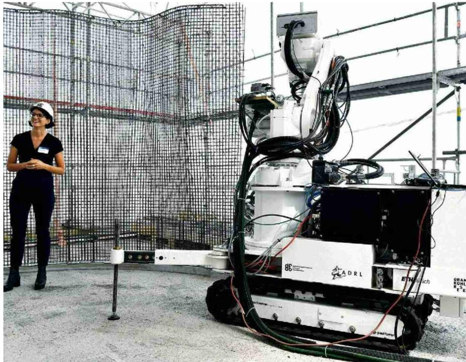
**Dieser Roboter produziert ein Stahdrahtgitter, das die Betonwand stabilisiert.** KEYSTONE
