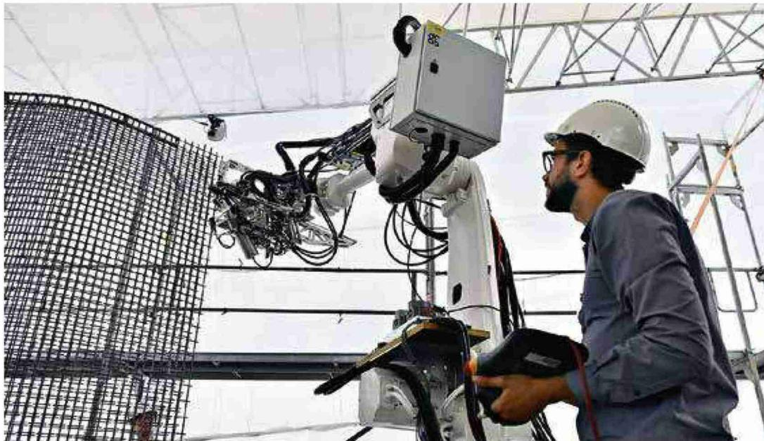
Le robot In Situ Fabricator permet d'effectuer des assemblages très complexes programmés à l'avance. (KEYSTONE/WALTER BIERI)
