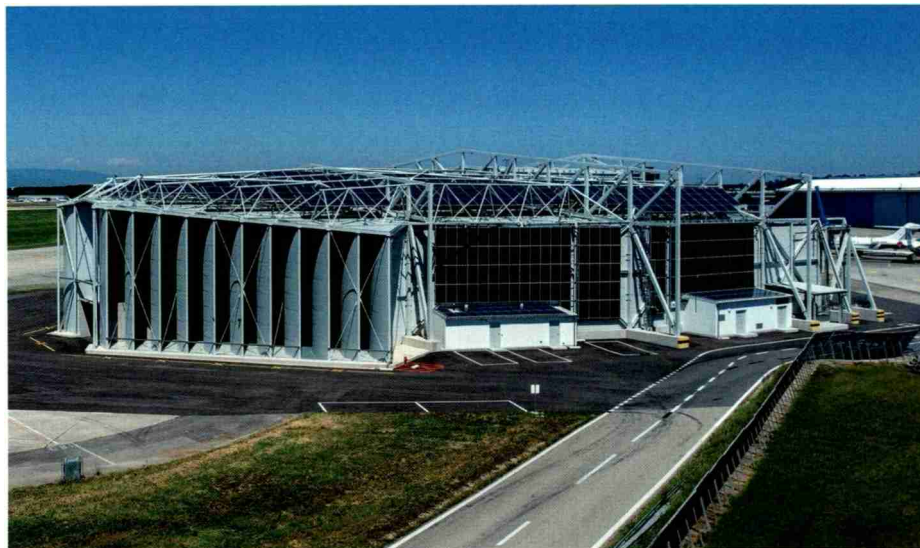
Die Solarmodule auf dem Dach und an der Fassade des neuen Schallschutzgebäudes von Genève Aéroport produzieren 200 MWh Strom pro Jahr.
