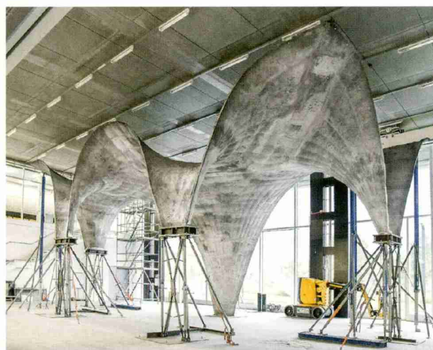
Ultradünn: Der Prototyp des Betondachs wurde an der ETH Zürich entwickelt. Als Schalung diente ein Textil aus Polymeren.
