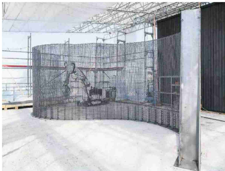
Der mobile Bauroboter «In Situ Fabricator» bei der Herstellung einer doppelgekrümmten «Mesh Mould»-Wand für das DFAB House.
