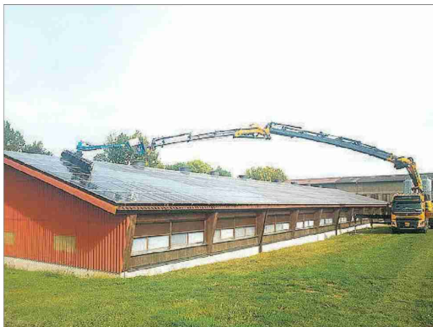
Un camion muni d'un bras articulé qui permet de nettoyer de plus grandes surfaces.
