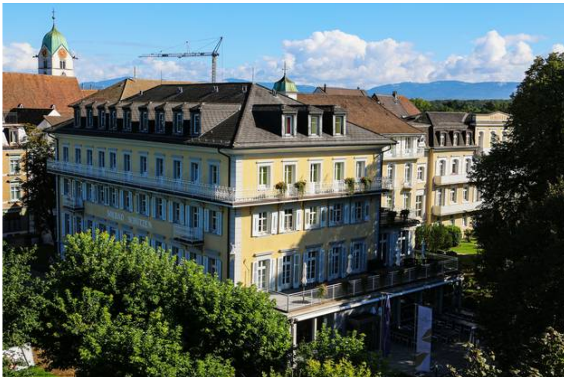
Rheinfelden, 25. Februar: Der «Schützen» wird derzeit umgebaut. Im April eröffnet das Restaurant wieder,
